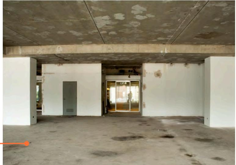
Se realizó una demolición selectiva y desmontaje total de instalaciones existentes, conservando únicamente los baños, los cuales fueron renovados.
